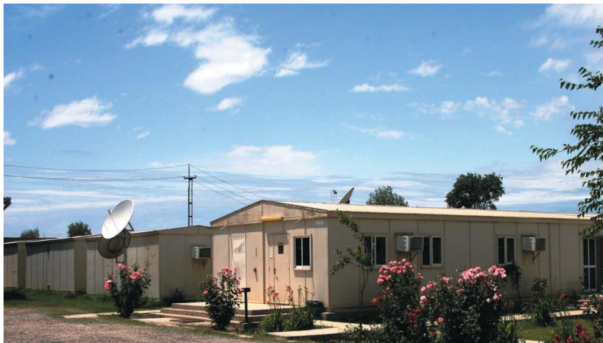
NPC油田现场营地
