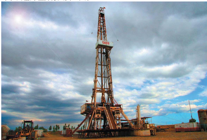
CNPC油田钻井现场
