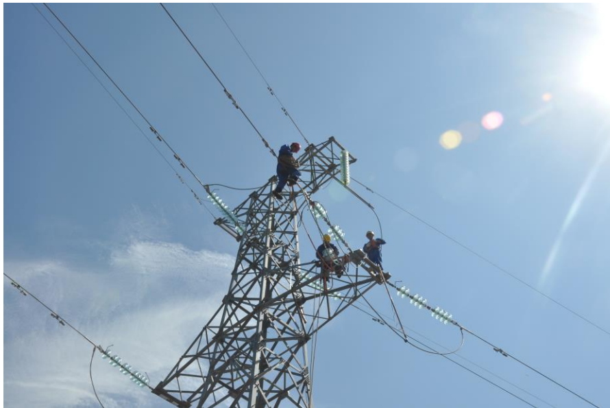
中核二二公司承建的东帝汶国家电网项目
