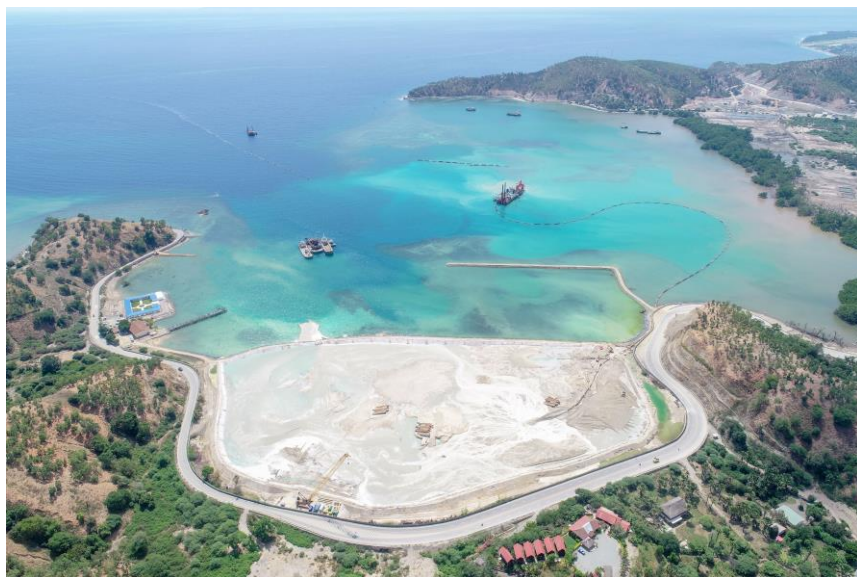
中国港湾公司承建的东帝汶蒂坝港项目
