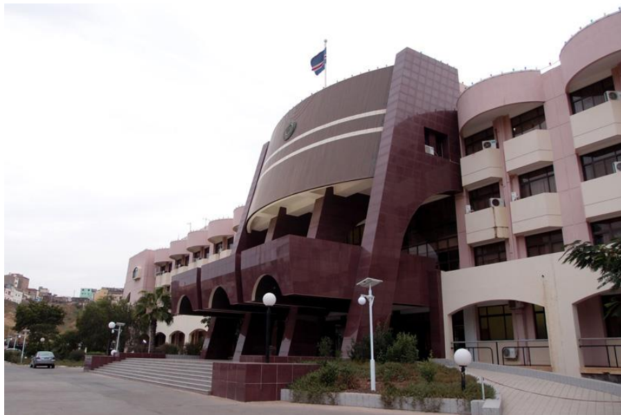
佛得角政府办公大楼
