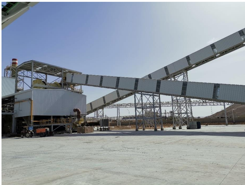
东华科技承建突尼斯化工集团项目
