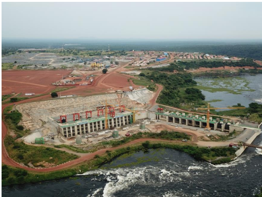
卡鲁玛水电站
