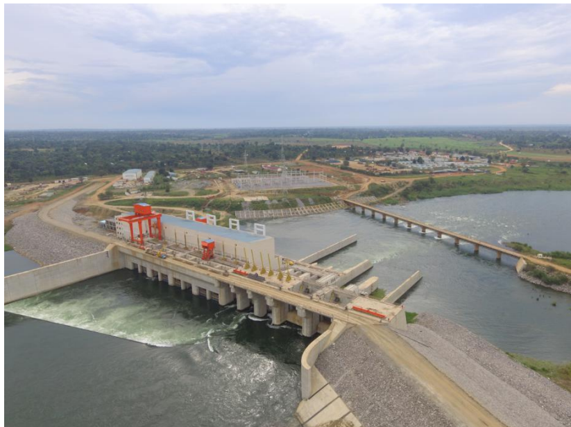
伊辛巴水电站
